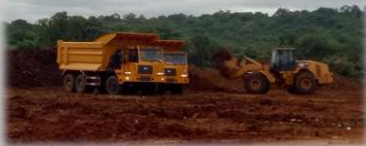
塞内加尔铁矿施工现场。 Senegal iron ore construction site.
